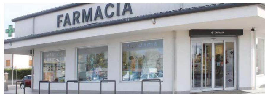
Opere di adeguamento normativo e sostituzione ingressi esistenti con porte automatiche antipanico
