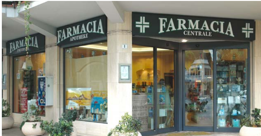
Porte automatiche e vetrine con profilati e vetri ad alto isolamento termico
