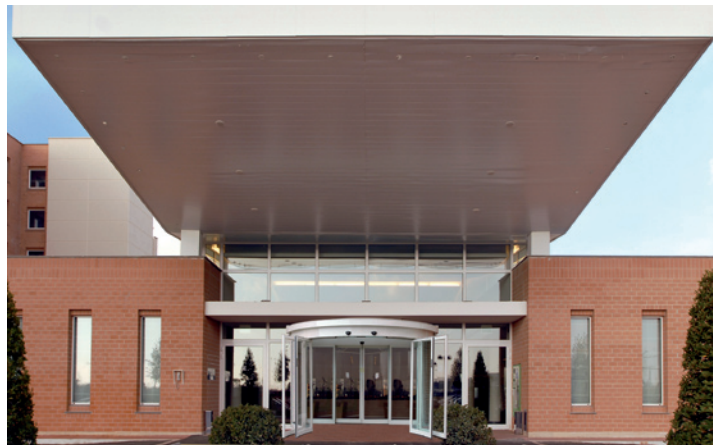
BUSSOLA COMPOSTA DA PORTA SCORREVOLE LINEARE PONZI E PONZI ARCO TOS CON ANTE IN POSIZIONE DI VIA DI FUGA
