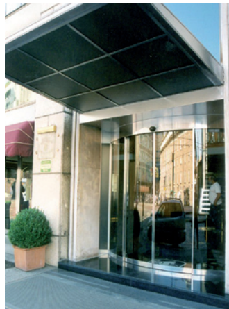
PORTA AUTOMATICA RIBASSATO IN POSIZIONE DI CHIUSURA. HOTEL MILANO
