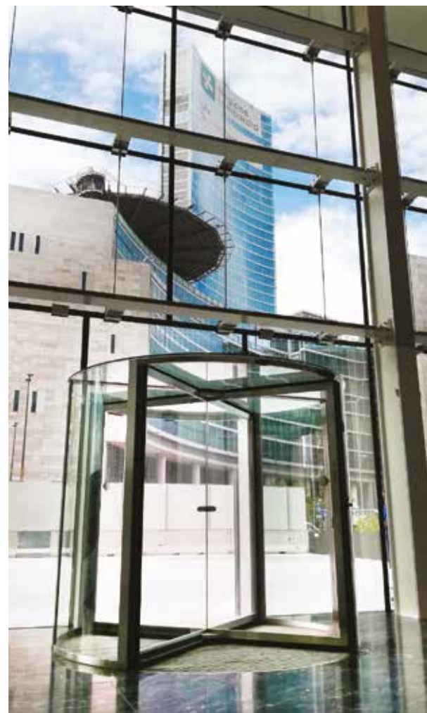
Porta Girevole automatica a 4 ante Ponzi PG Vitrum con automazione a pavimento, posizionata sotto lo zerbino tecnico ad incasso Ponzi Tire
