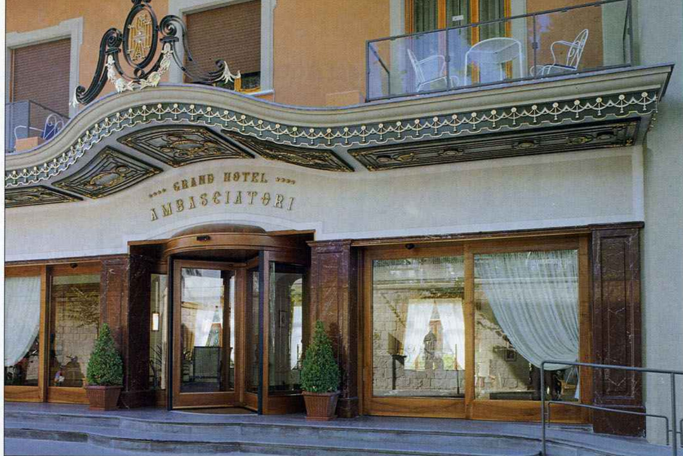
Nella pagina di apertura, l'originale facciata del Grand Hotel Paradiso di San Giovanni Rotondo, sul Gargano, con le due porte girevoli della Ponzi Ingressi Automatici. Qui sopra, la porta girevole Tourniket in legno installata al Grand Hotel Ambasciatori di Sorrento. A destra, la bussola girevole installata al Grand Hotel Villa Serbelloni di Bellagio, sul lago di Como
