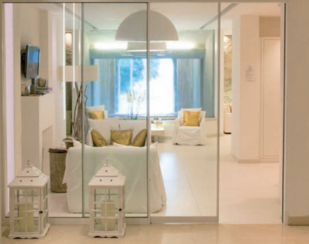
Compartmentazione interna zona SPA - Porta scorrevole Ponzi con profili a sezione ridotta da mm 20 - Villa Le Maschere Resort (FI)
