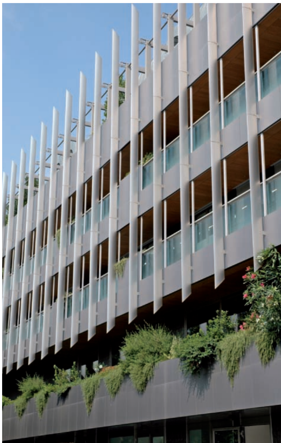
Infissi di edificio sostenibile con infissi Ponzi a taglio termico e finiture in alucobond
